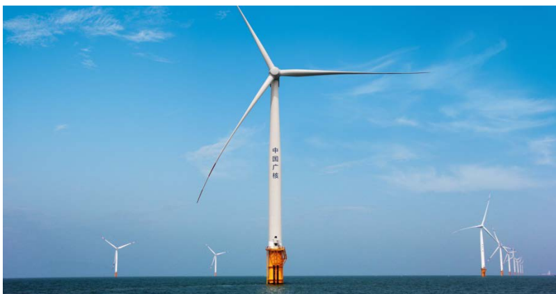
上海东海大桥风电项目
