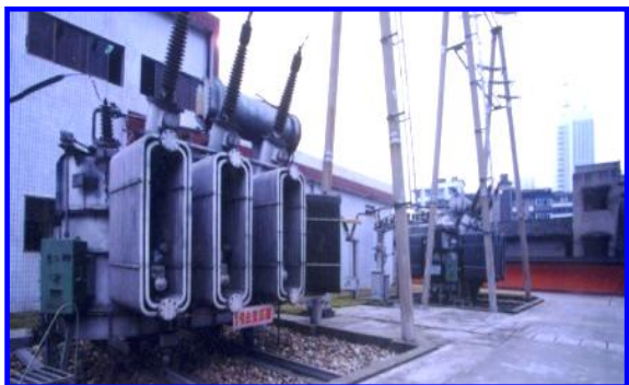
用户：金沙江溪洛渡水电站 变压器厂：特变电工衡阳 变压器型号：SSP-H--860000/500 开关型号：WDLV-1600/126-4×3
