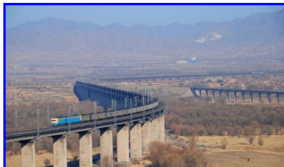
用户：大秦铁路 变压器厂：西安中特电 变压器型号：80000/55+5-3*6% 开关型号：SHZVI-1600/63C-10090
