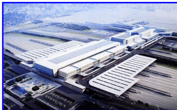
用户：虹桥枢纽想项目 变压器厂：云南变压器有限公司 变压器型号：SZ10-31500/220±8*1.25% 开关型号：CMIII350Y/126C-10193W
