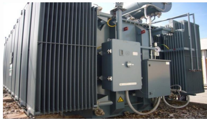
ENEL, 意大利 40MVA/132kV Type CM2
